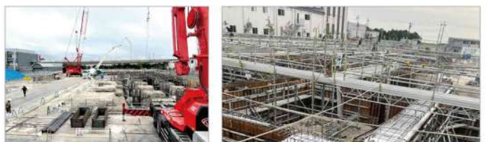
第二工場総敷地面積 2,200坪 / 建坪 6,393坪 既存工場との合算総敷地面積 3,700坪 / 建坪 7,385坪
